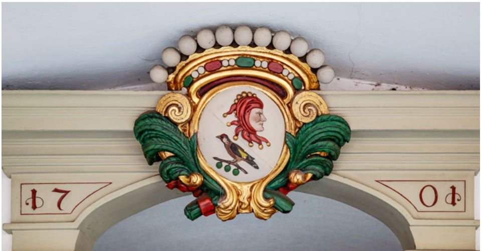
Haus der Gesellschaft zum Distelzwang Wappen über dem Hauseingang und Steinmetzarbeit an der Fassade Gerechtigkeitsgasse 79, Bern
